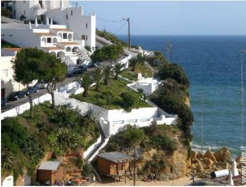
vista dalla terrazza sul tetto
