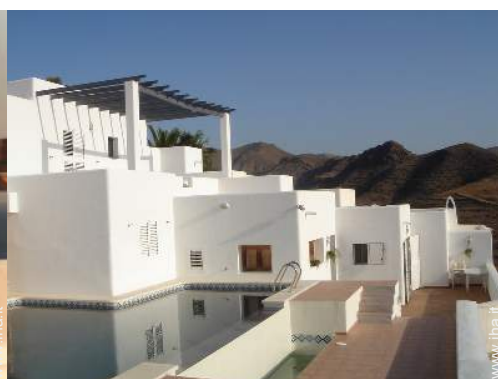
Piscina a sfioro
