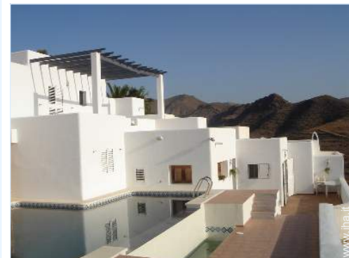
Piscina a sfioro
