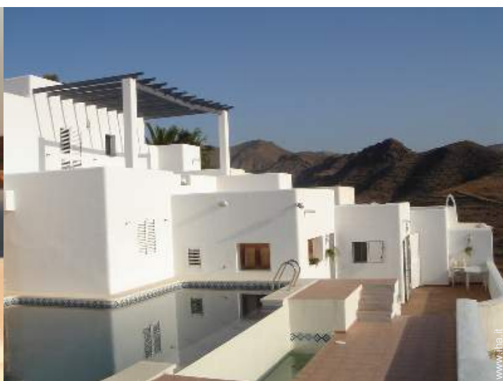
Piscina a sfioro
