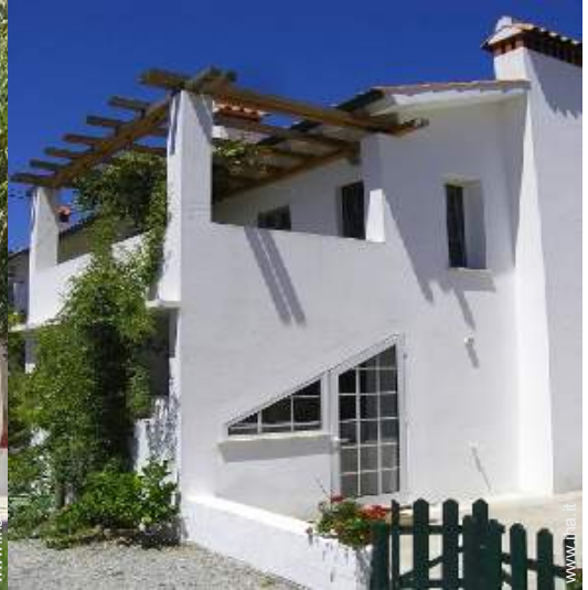
terrazzo sul tetto
