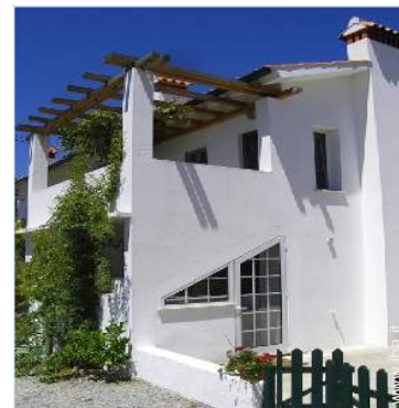
terrazzo sul tetto
