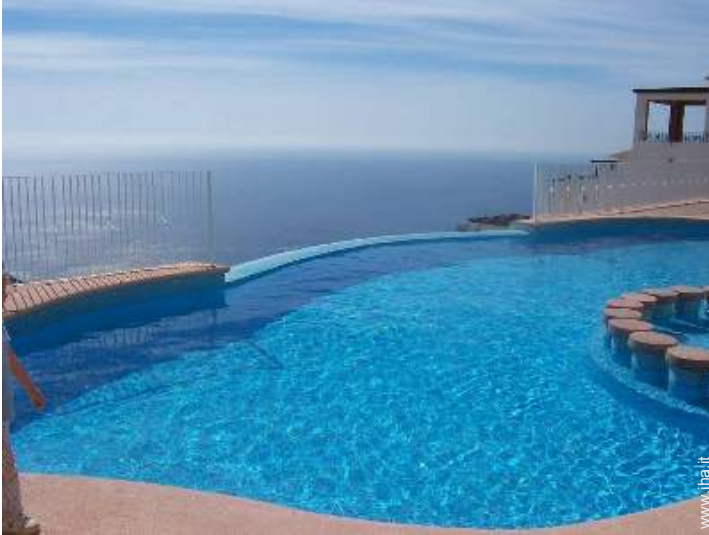
Piscina a sfioro
