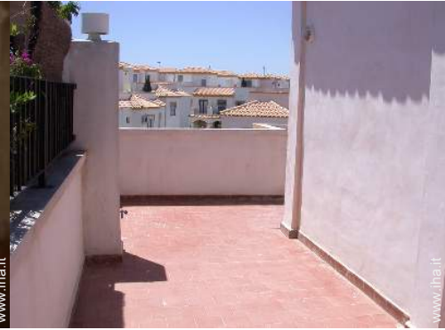
terrazzo sul tetto
