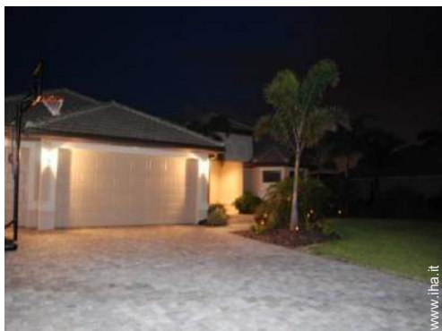
sistema di illuminazione
