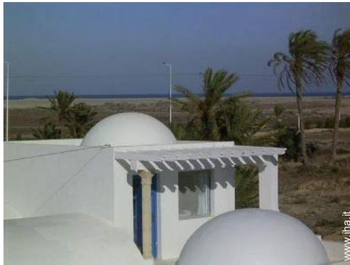
vista dalla terrazza sul tetto
