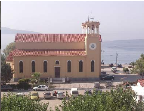
vista dalla terrazza sul tetto
