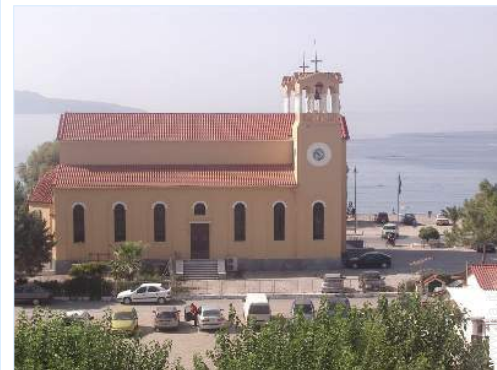
vista dalla terrazza sul tetto
