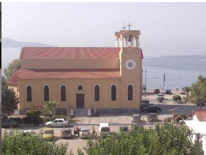
vista dalla terrazza sul tetto
