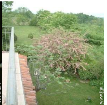
vista dalla terrazza sul tetto
