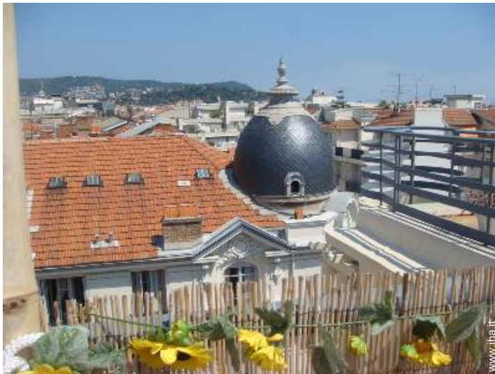
vista dalla terrazza sul tetto
