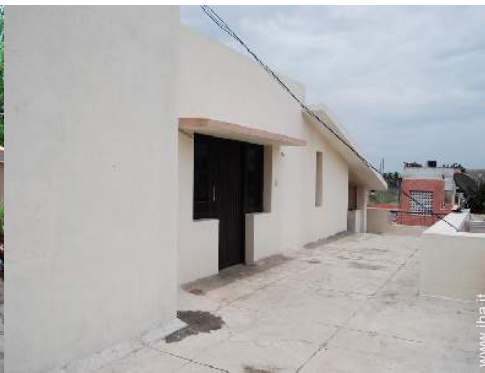
terrazzo sul tetto
