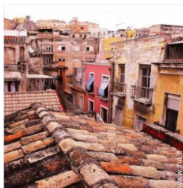
vista sui tetti
