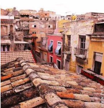
vista sui tetti
