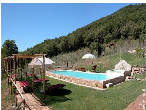
Piscina a sfioro
