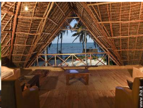
vista dalla terrazza sul tetto
